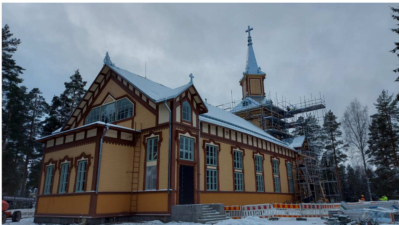
Vilppulan kirkon ulkopuolinen korjaus ja maalaus – telineiden poistoa 22.11.2023
